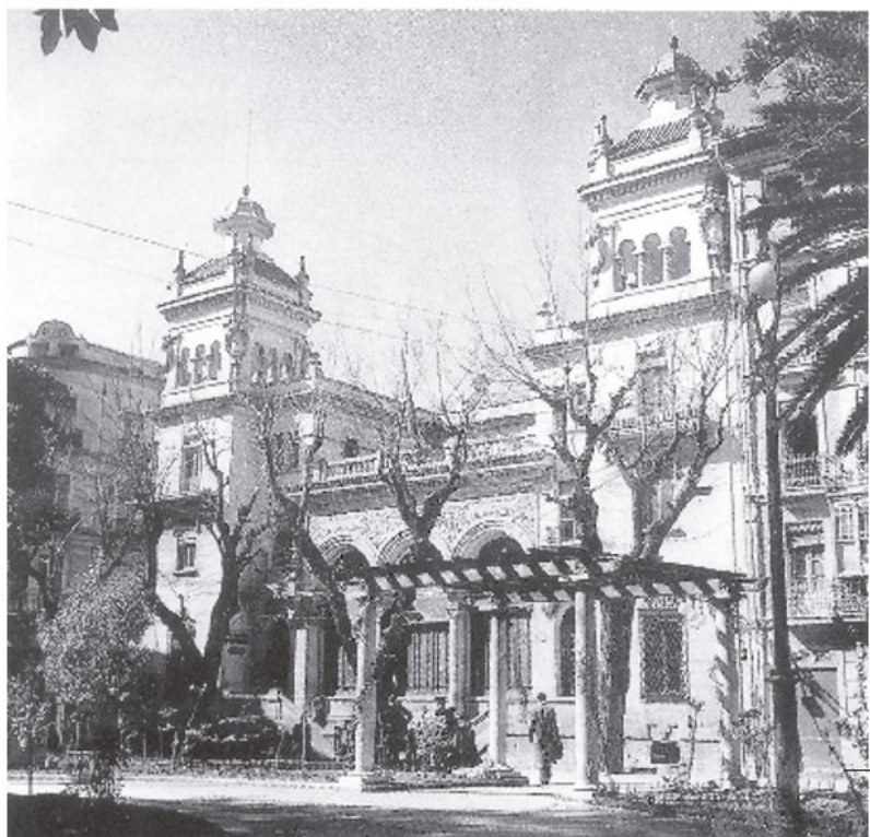
Façana original de la seu de Correus i Telègrafs segons el projecte de Luis Ferrero. Font: Sánchez, 1944. Arxiu Municipal d'Alacant (AMA)
