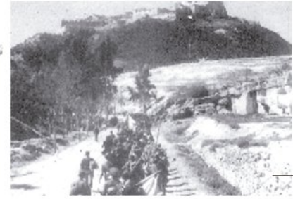
Tropes italianes entrant a Alacant (abril 1939), acabada la guerra incivil. A l'esquerra, la Goteta, amb notable fronda arbòria.
