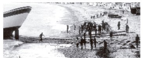
El varador, com aquest del Campello, estava a la vora de la mar. Per un pla inclinat, amb parats i fent servir la força humana per espentar, la força animal o màquines per estirar, podien varar la barca.
