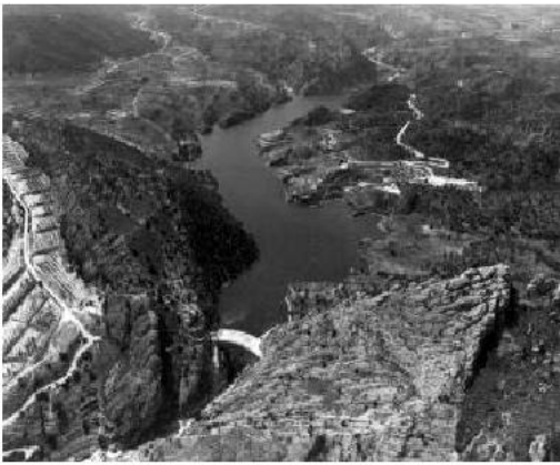
Pantà de Tibi, a l'entrada de la subcomarca de l'Horta d'Alacant. De 41 m d'altura i tipologia d'arc-gravetat, va ser bastit entre 1580 i 1594 en temps de Felipe II
